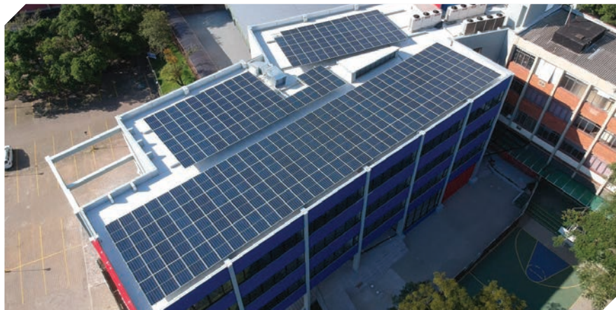
Cobertura fotovoltaica do novo prédio do Colégio
